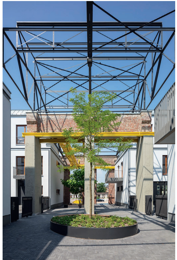
Bild 8. Eine mittig angeordnete, ca. 11 m breite offene Magistrale erschließt die Wohnungen in der ehemaligen Werkshalle
