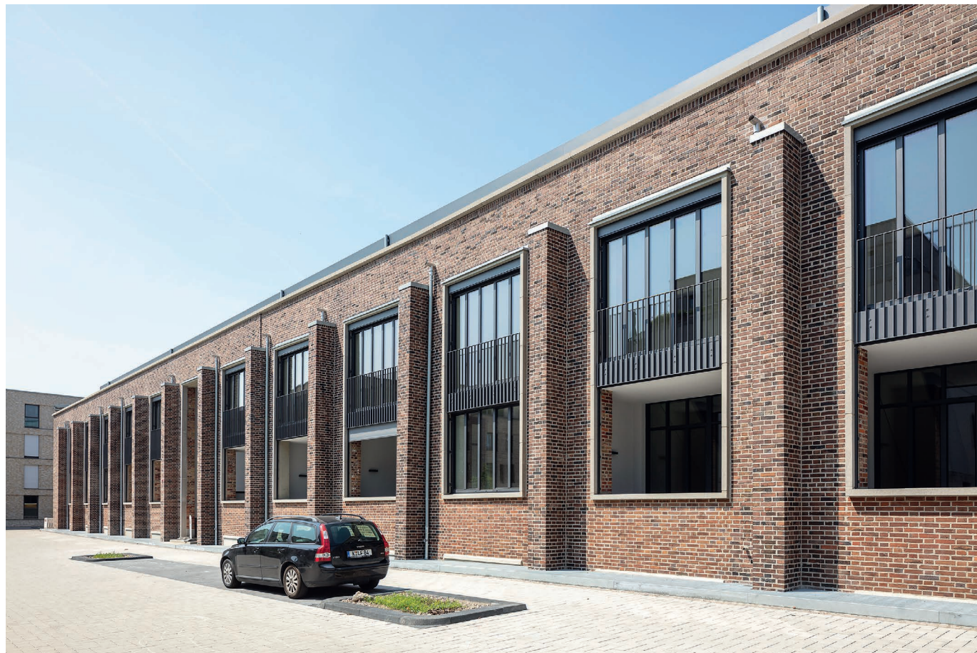
Bild 1. Sanierte Klinkerfassade der Halle 17 im Kölner Clouth-Quartier
