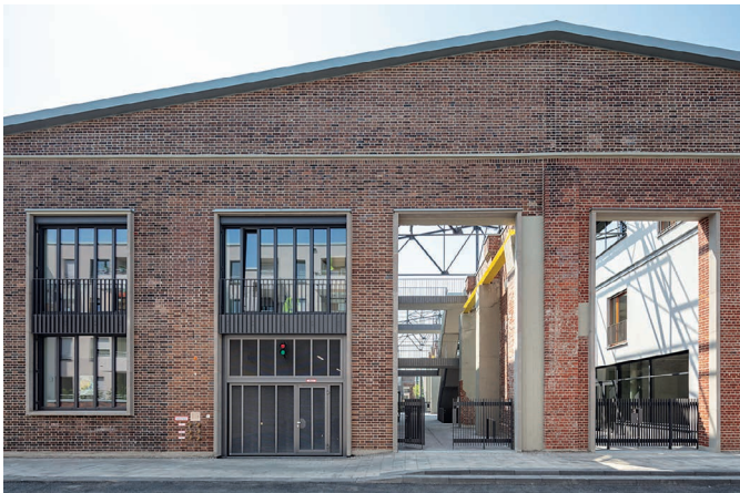
Bild 7. Die unterschiedlichen Bauphasen sind an den sanierten Fassaden ablesbar
