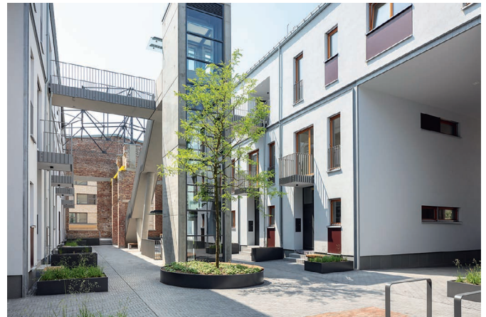
Bild 9. Über frei in den fußläufigen Durchgang zum Luftschiffplatz eingestellte, luftige Treppenaufgänge, Aufzugstürme und Brücken erreichen die Bewohner ihre Wohnungen (Fotos 1, 6–9: Jörg Hempel, Aachen)
